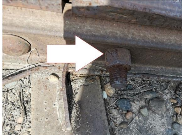
1.4. Зазоры в стыках направляющих превышают максимально допустимое значение (при температуре окружающего воздуха +20 градусов равное 3мм.), по оси А до 21мм., по оси Б до 18мм.
