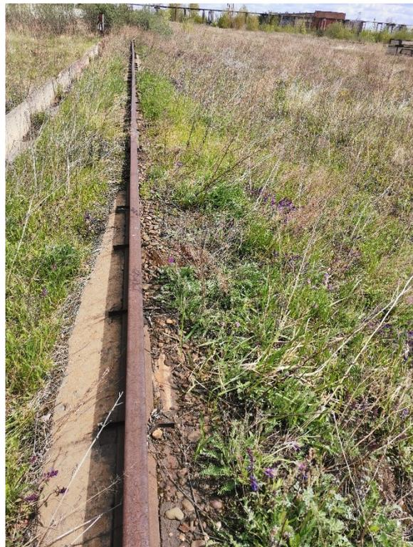
6.2. От заявленной протяженности кранового пути (600м.) фактически отсутствует половина, отсутствуют балки, направляющие и частично кабельный лоток.
