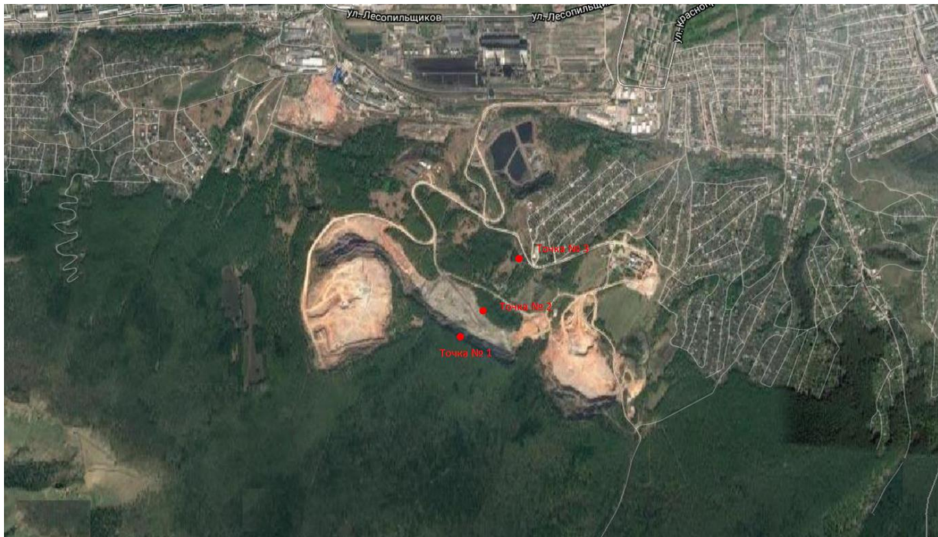
Рисунок 11 – Карта – схема расположения точек отбора проб атмосферного воздуха в районе золоотвала № 2 Красноярской ТЭС-2
