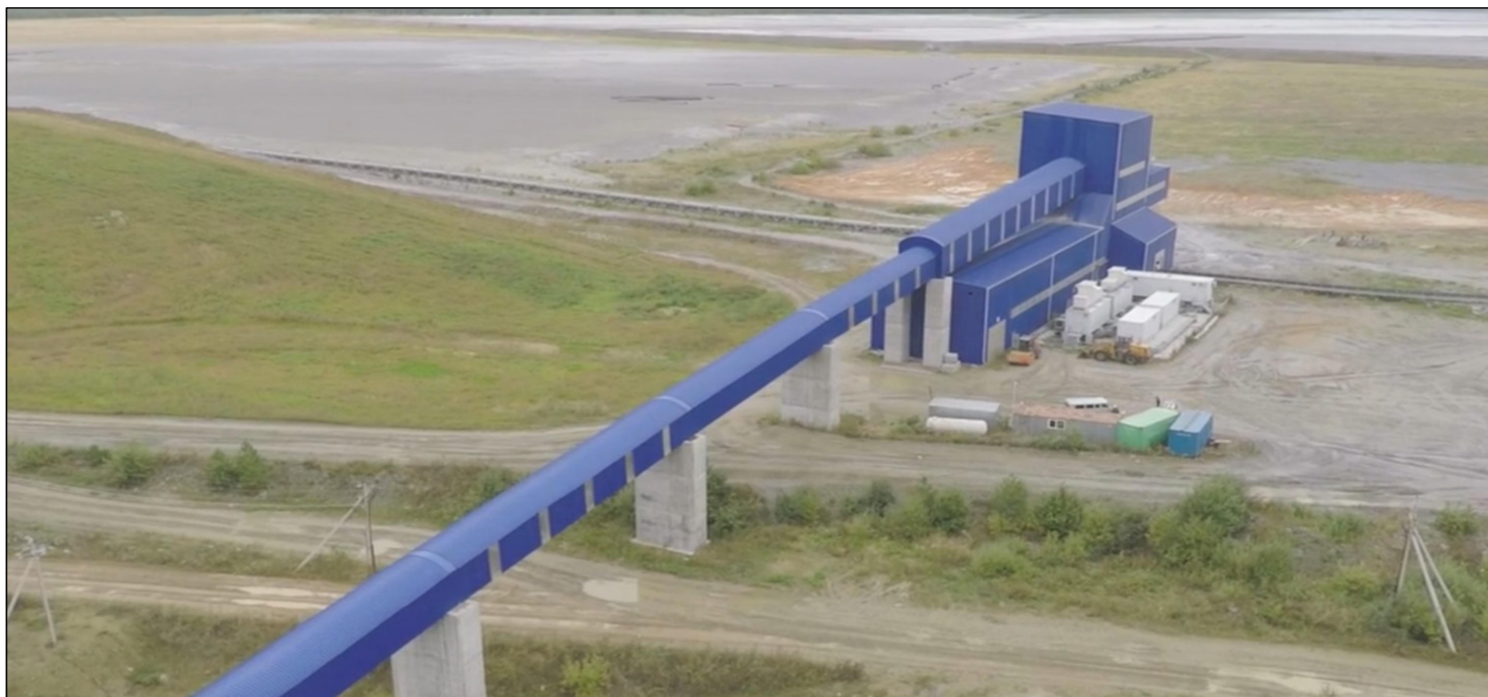
Фото 4 – Труболенточный конвейер Рефтинской ГРЭС
