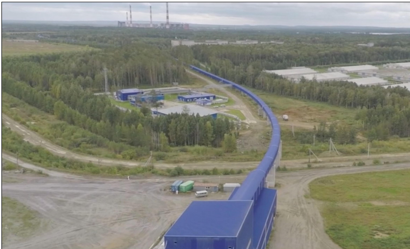
Фото 3 – Труболенточный конвейер Рефтинской ГРЭС
