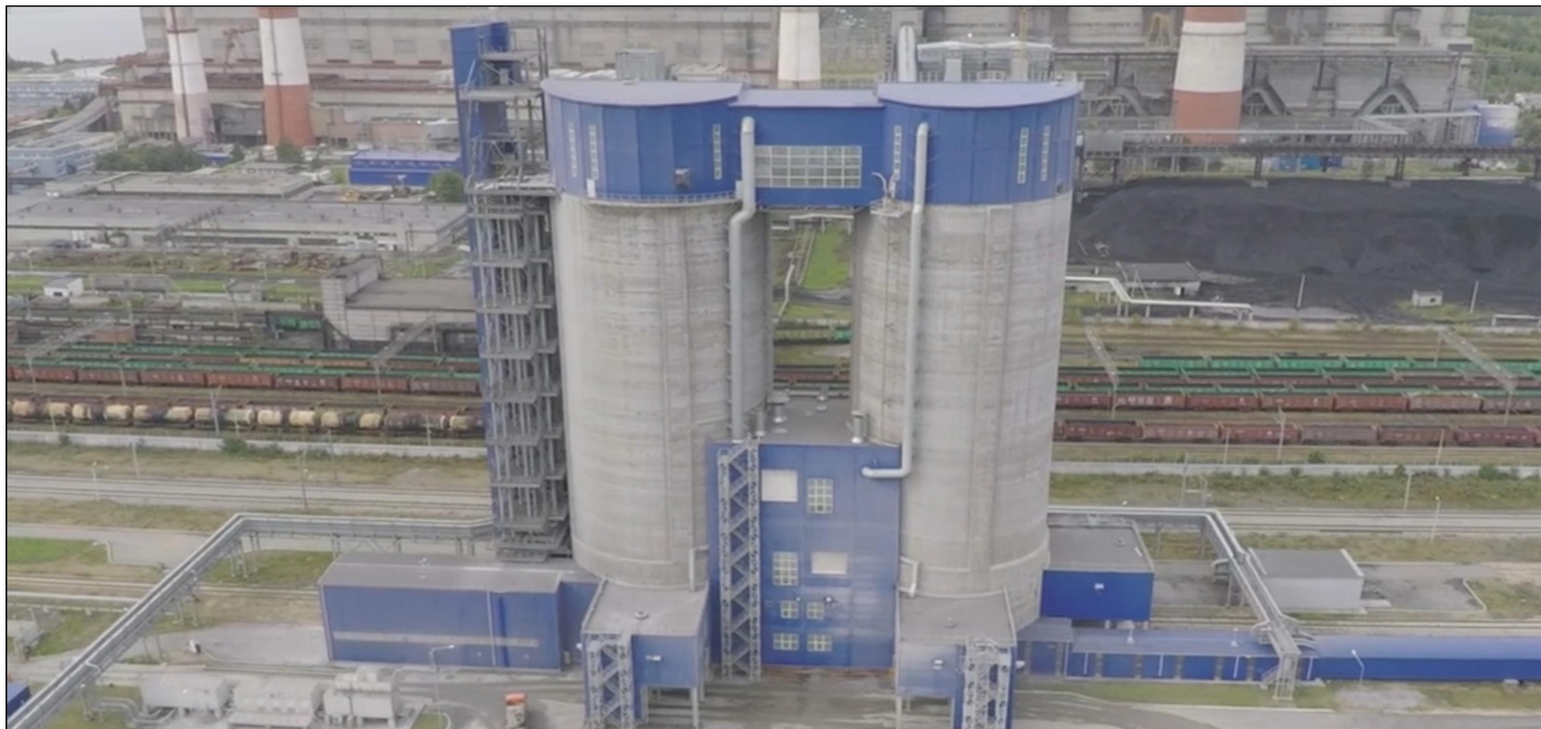
Фото 1 – Силосы Рефтинской ГРЭС
