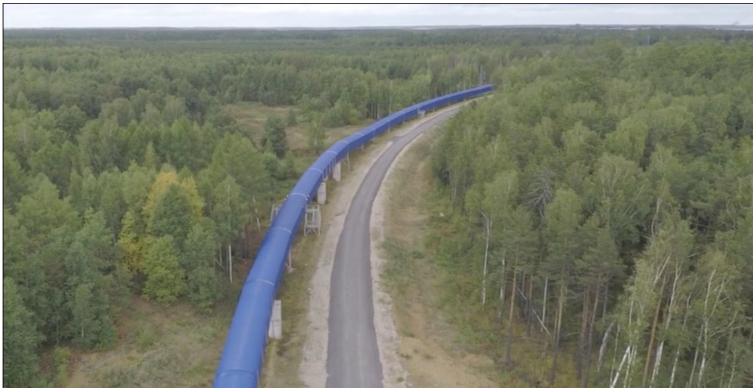
Фото 2 – Труболенточный конвейер Рефтинской ГРЭС
